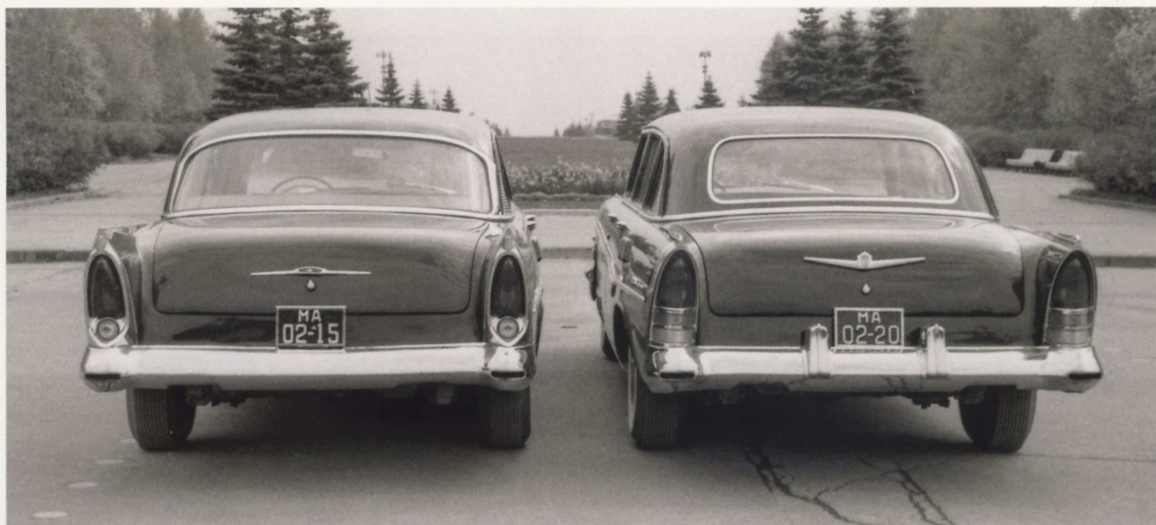
Вид сзади модернизированного ЗИЛ-111 (слева) и серийного ЗИЛ-111 (справа)
